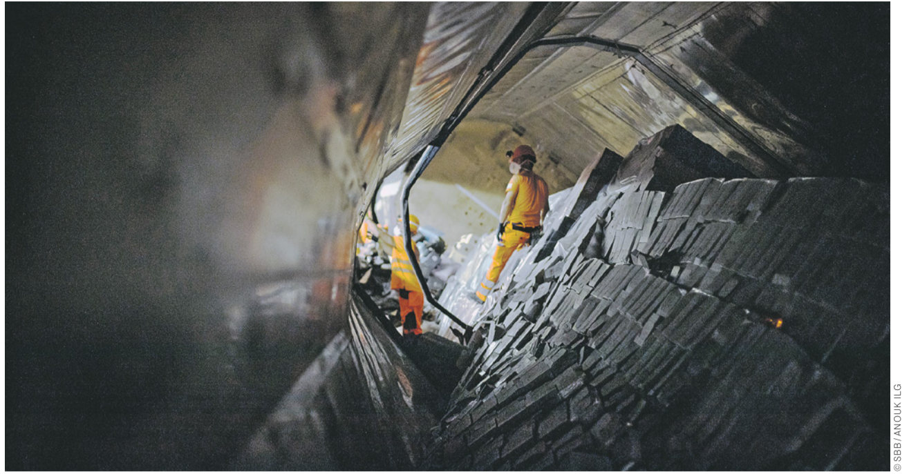
Lavorare in galleria a 40 gradi comporta uno sforzo fisico importante.
